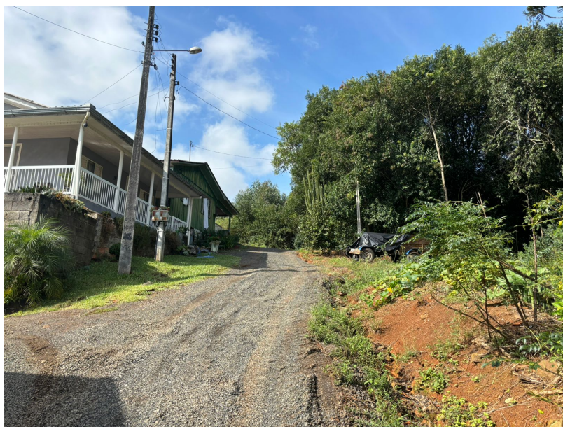
Figura 6 - Servidão São Sebastião
